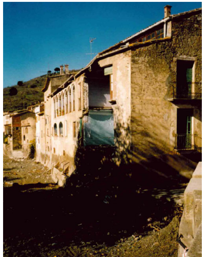
Efectes de la riuada, Porrera, 1994 (AGDT)
