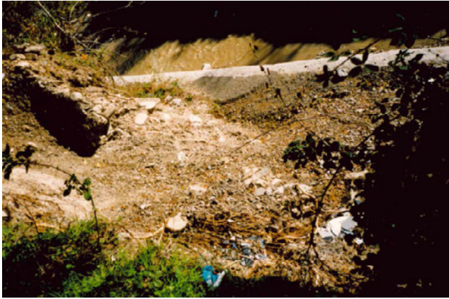
Efectes de la riuada, Porrera, 1994 (AGDT)
