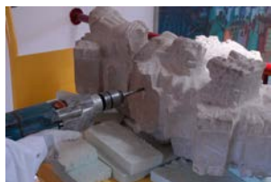
Realització de forats per a inserir espigues
