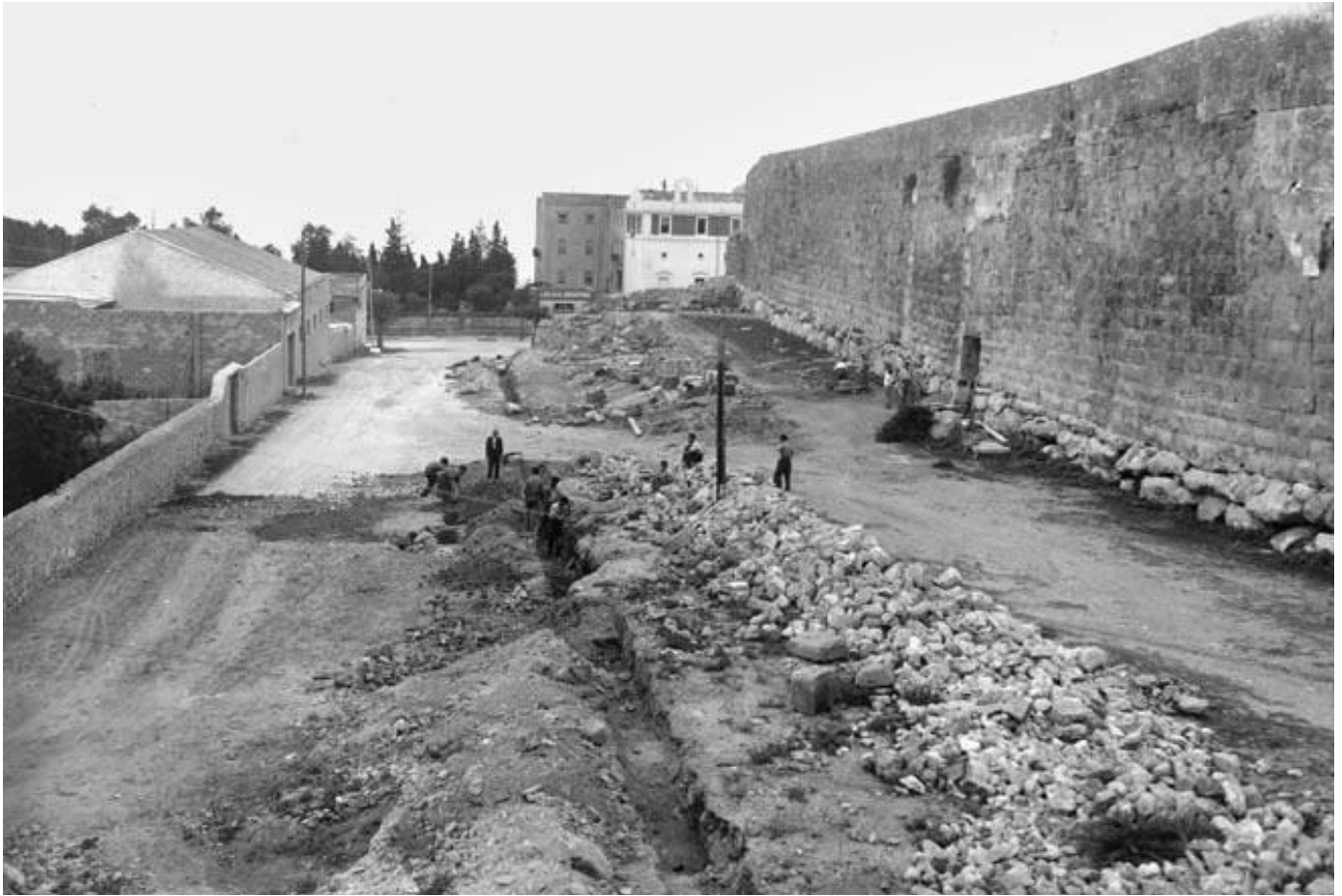
La Beneficència al final del passeig de Torroja, actual Palau de la Diputació de Tarragona (1940) (fbk, 'Tarragona Antiga', pujada per Òscar Piqué el 17-01-2021).
