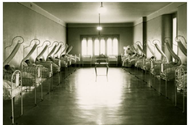
Sala de deslletament de la Casa de la Beneficència. Autor desconegut. Any 1926. AGDT 0008731
