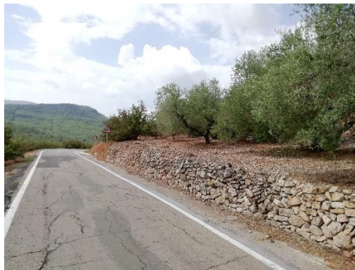
Fotografia 4. Marge de la carretera delimitat per murs de pedra seca.
