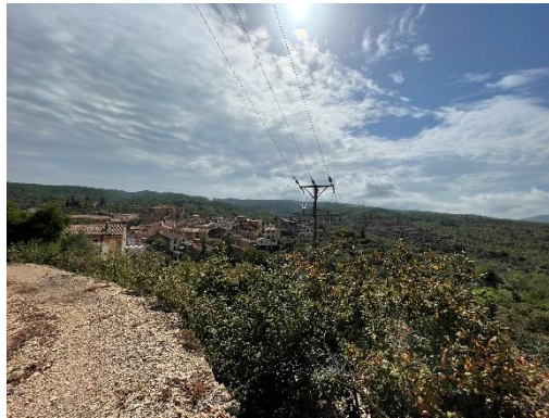
Fotografia 6. Presència de línies elèctriques i murs de pedra seca.
