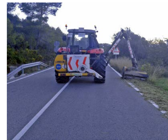
Actuació a la zona de vorals i cunetes.
