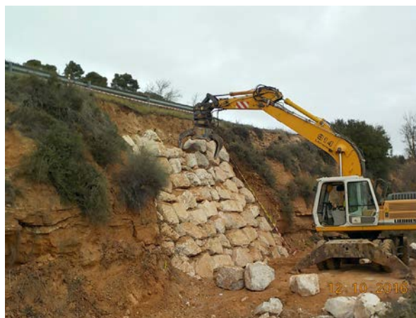
Reparació amb escullera a Montbrió de la Marca, TV-2333, PK 2+170.
