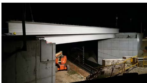
Muntatge de bigues i prova de càrrega en l'execució de les obres de "Condicionament de la carretera T-704 entre la T-11 i l'Aleixar. 1a fase (tram T-11 - Maspujols)".
