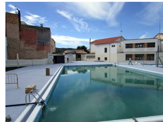
Remodelació de la piscina municipal de Sarral.
