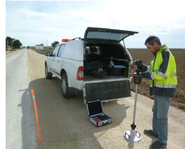
Comprovació del nivell de compactació a les obres de "Condicionament de la carretera TV-3405 des de la TV-3404 a la platja dels Eucaliptus. 2a fase".
