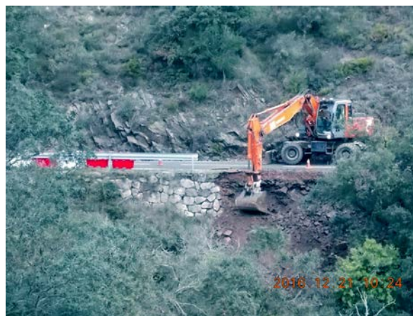
Reparació d'enfonsament de calçada a la T-313, PK 22+254.
