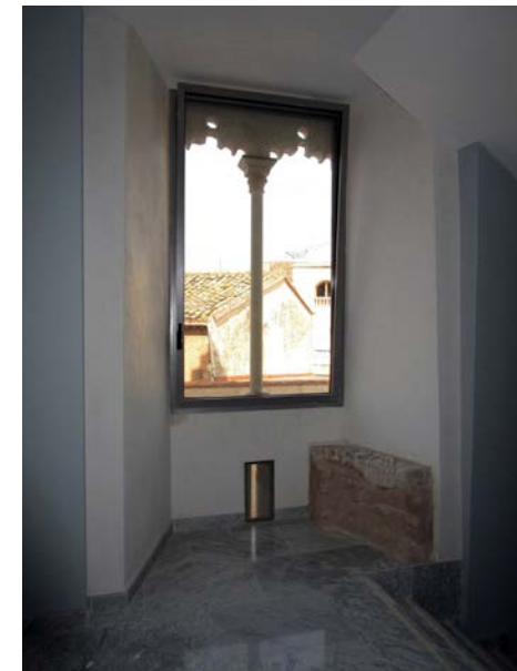
Reforma i rehabilitació de la zona noble del castell de Rodonyà.
