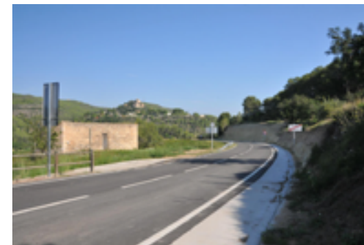
Actuacions puntuals a l'accés a Vespella, carretera TV-2021.
