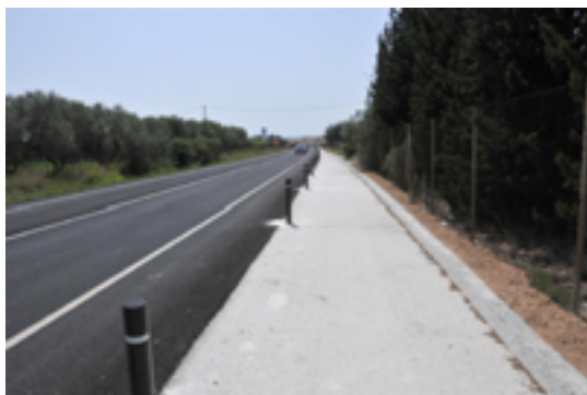
Millors puntuals de seguretat i drenatge a la carretera TV-2041, a Roda de Berà.
