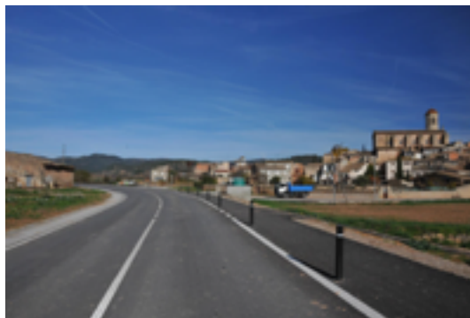
Condicionament de la carretera TV-2338 a Blancafort.
