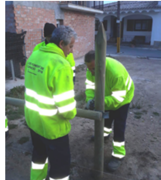
PO Baix Ebre: reposició de baranes a la Via Verda.
