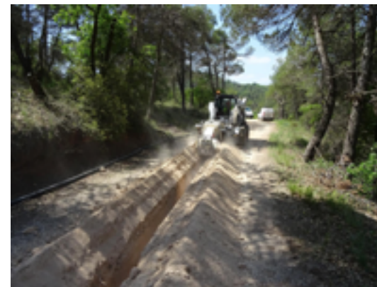
Direcció d'obra de la nova connexió a la xarxa de la Mancomunitat d'Aigües de les Garrigues al dipòsit de l'Espluga Calba, per a l'abastament d'aigua potable a Senan.
