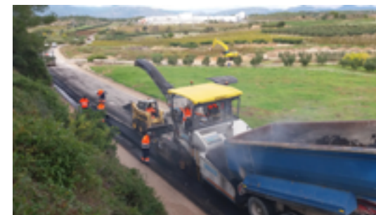
Execució de la capa de trànsit a la carretera T-223, entre Vallmoll i la Secuita.
