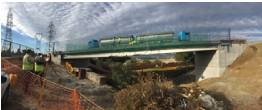
Control geomètric per a la prova de càrrega al pont sobre la carretera T-704.
