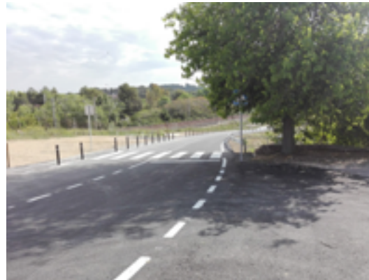
Millora de l'accés a la platja Llarga, carretera TV-2038.
