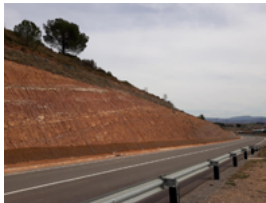
Protecció de talús amb malla a la carretera TV-7001, des de l'N-240 fins a l'Espluga de Francolí.
