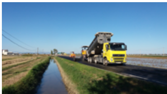
Reforçament del ferm a la carretera TV-3404, Sant Jaume d'Enveja.
