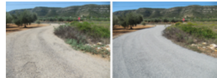
Treballs de pavimentació del camí del Tossalet. Ajuntament de Freginals. Estat inicial i final.
