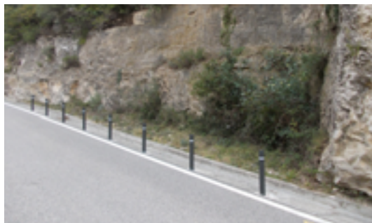
Millora de la seguretat a la carretera T-3225, de Cornudella de Montsant a Siurana, PK 4+600.
