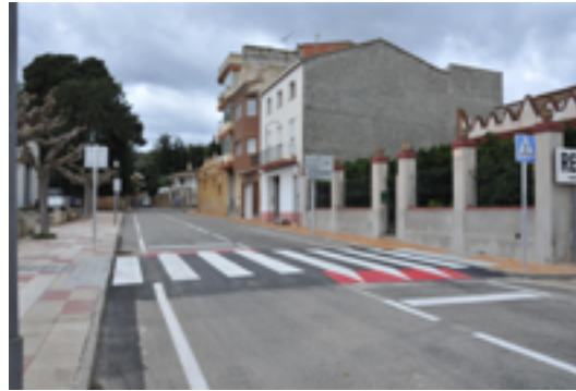
Reductor de velocitat tipus pas de vianants a Miravet, carretera T-324.
