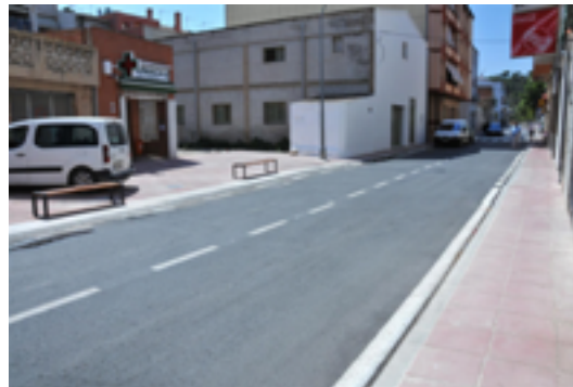
Condicionament de la travessera a Tivenys, carretera T-301.
