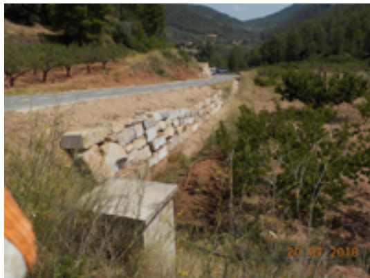
Construcció d'un mur d'escullera a la carretera TV-3541, PK 0+700, de Xerta a Paüls.
