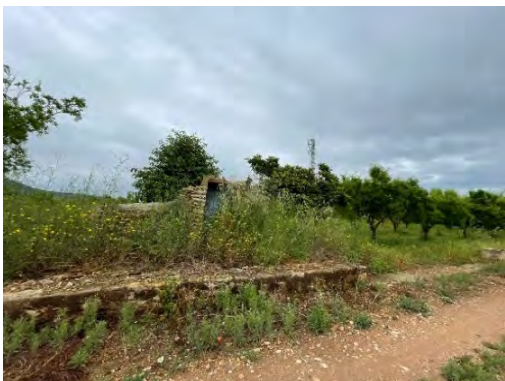
Imatge 25. Edificació agrícola abandonada al PK 0+520.
