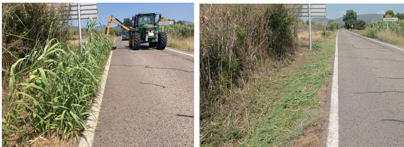
Estat abans i després de l'actuació de sega de cunetes a la carretera TV-7421, de Picamoixons a la C-37.
