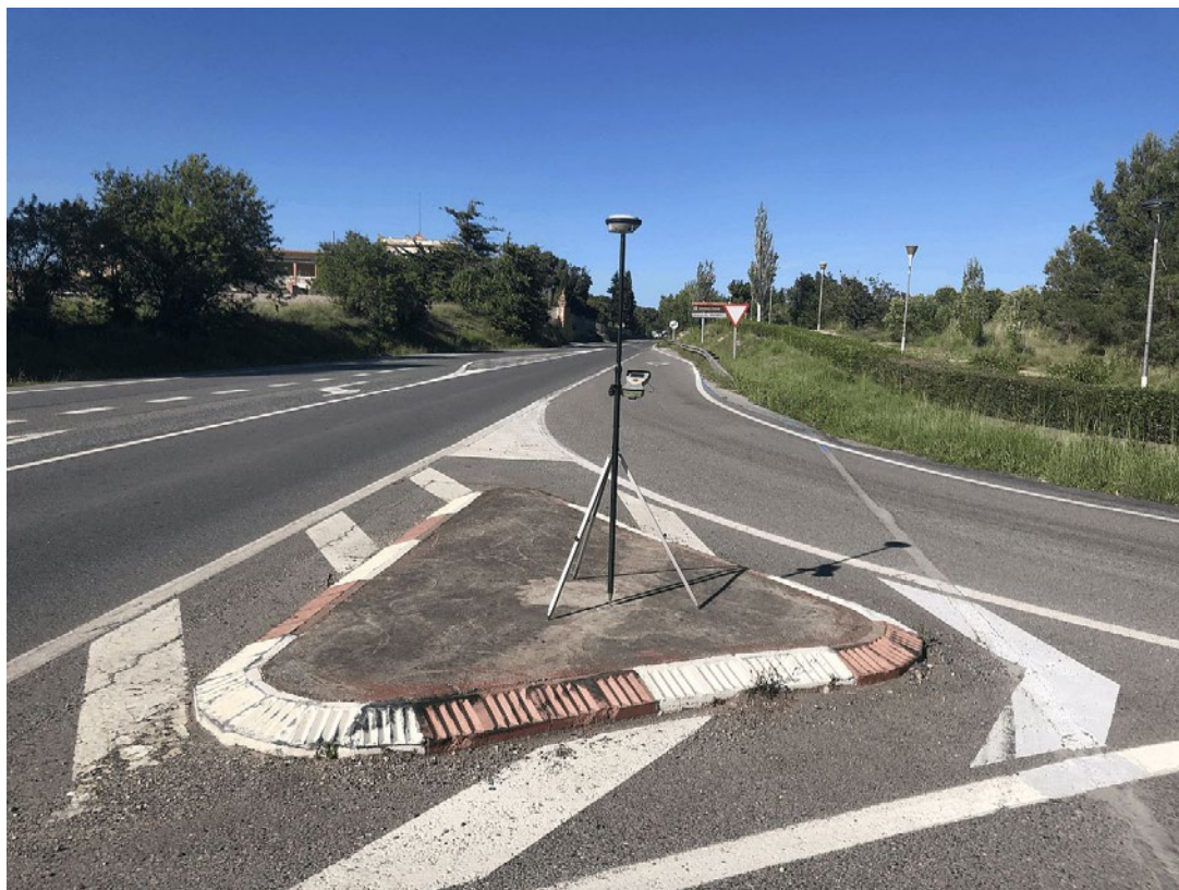
Aixecament topogràfic a la carretera TV-2034, de Valls a Vilabella.
