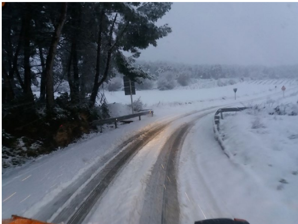
Treballs de viabilitat hivernal a la T-201, de Santa Coloma de Queralt a Esblada.
