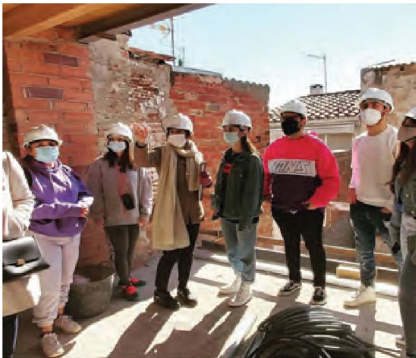
Visita obres en construcció
