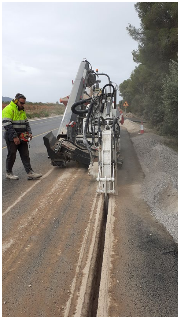
Canalització per al pas de fibra a la TP-2031.
