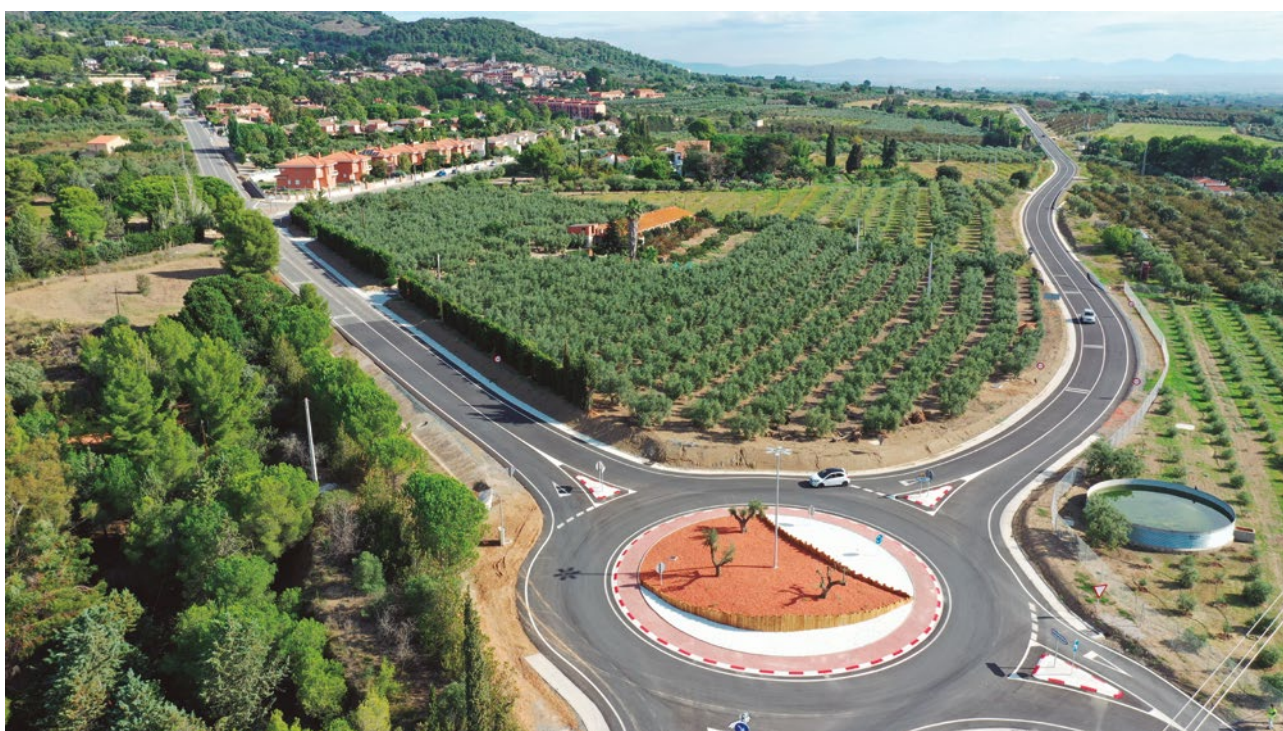
Condicionament de la carretera T-3231, d'Almóster a la Selva del Camp.
