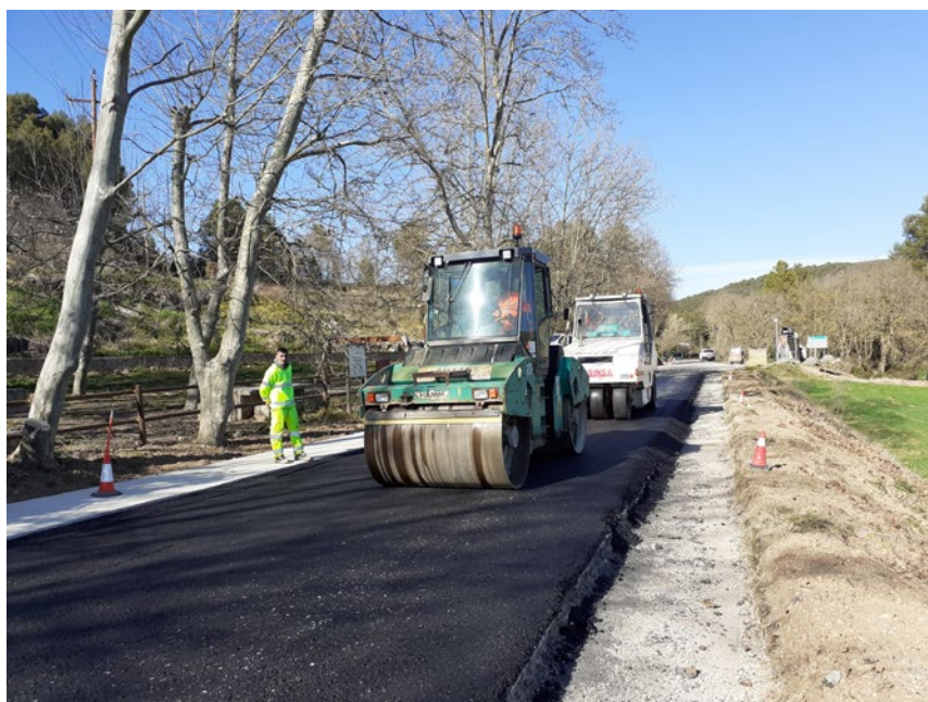
Reforç de ferm a la carretera TV-2441, Querol.
