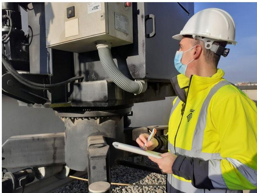
Tècnic de prevenció durant una inspecció d'instal·lacions.
