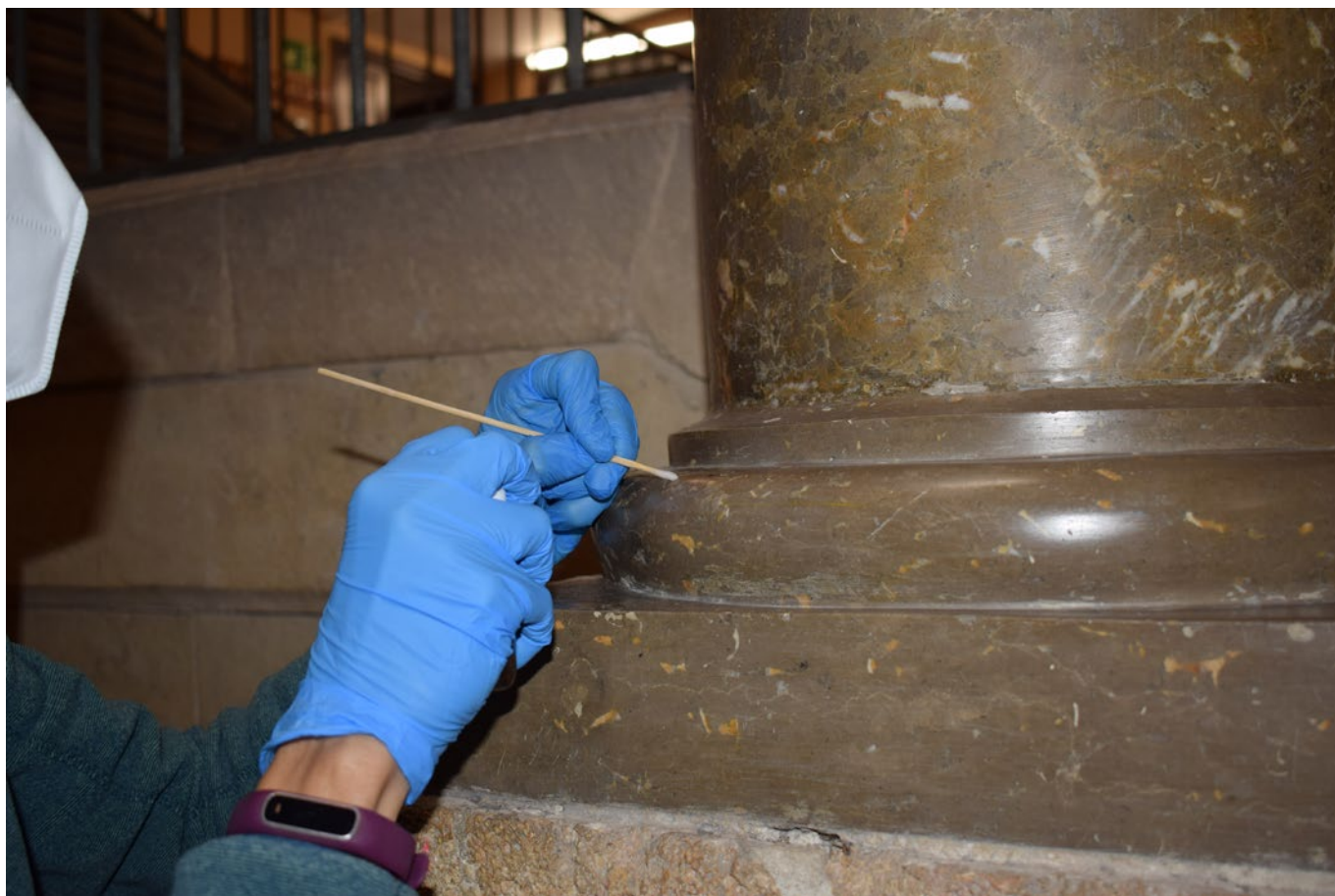
Assaig de neteja en una columna del vestíbul del Conservatori de Música de Tarragona.
