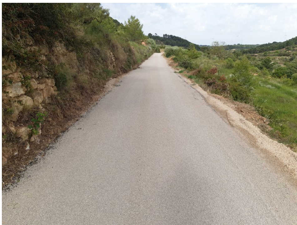
Treballs de pavimentació del camí de l'Auba. Ajuntament de Gandesa. Estat inicial i final.
