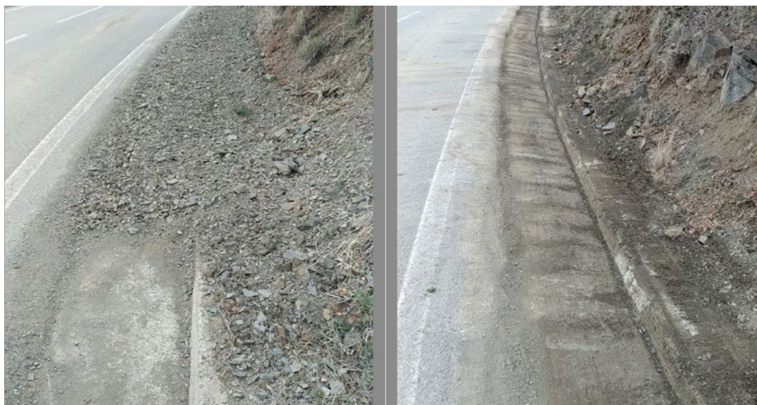
Neteja de cuneta a la carretera T-732.
