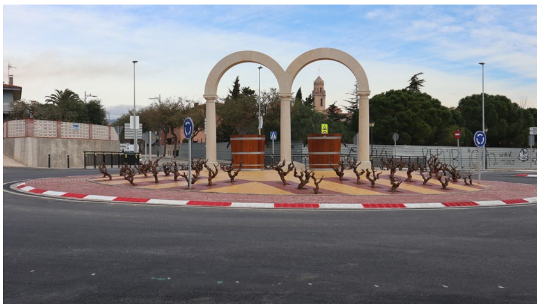
Rotonda a la intersecció entre la carretera T-314 i el camí de Sant Joan, a Vinyols i els Arcs.
