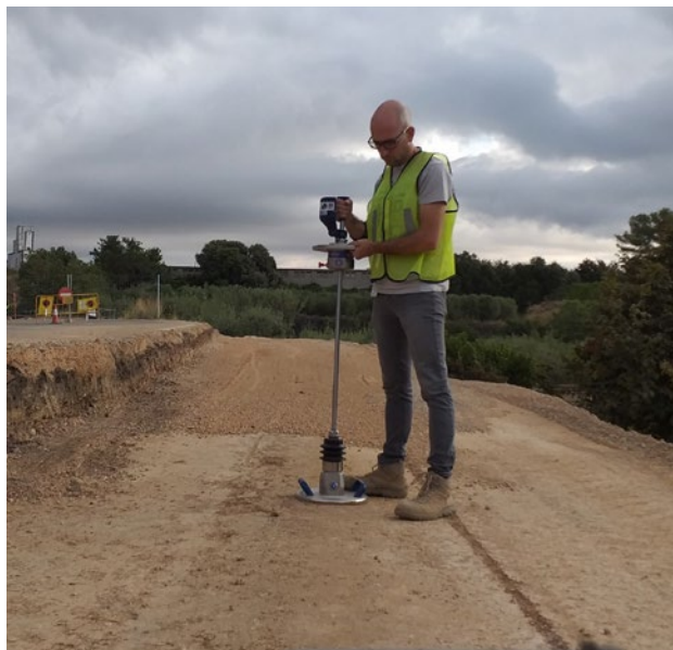
Prova de placa de càrrega dinàmica.
