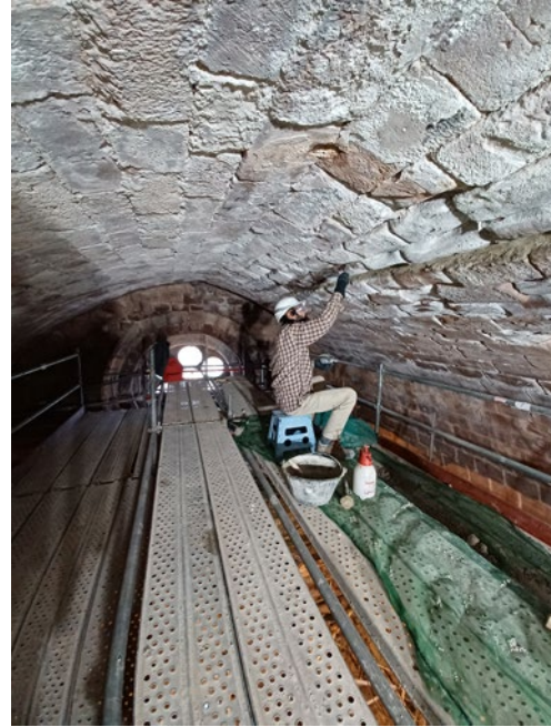
Restauració d'Escornalbou. Treballs de la volta de l'església.
