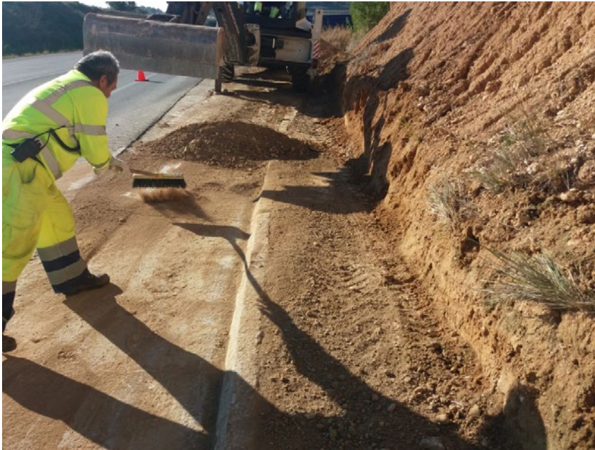
Neteja de cuneta.
