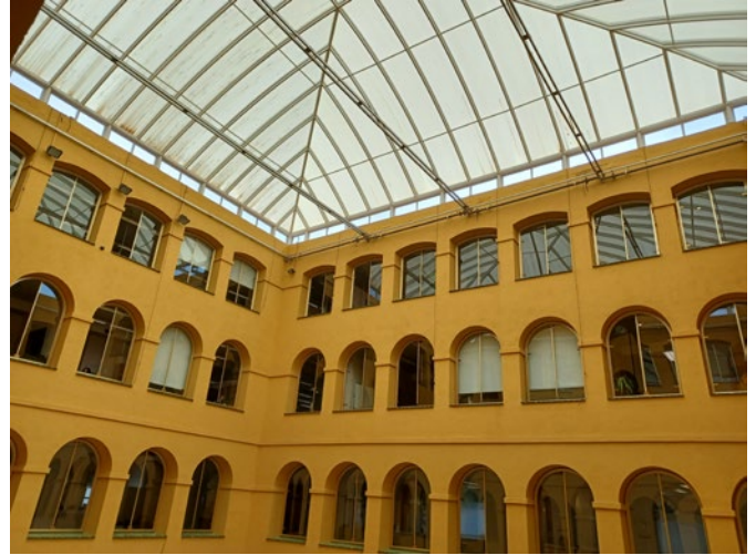
Restauració integral del Palau de la Diputació. Substitució de la coberta del pati/atri.
