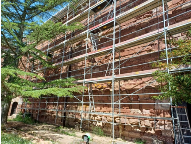
Restauració d'Escornalbou. Bastida al mur exterior de l'església.
