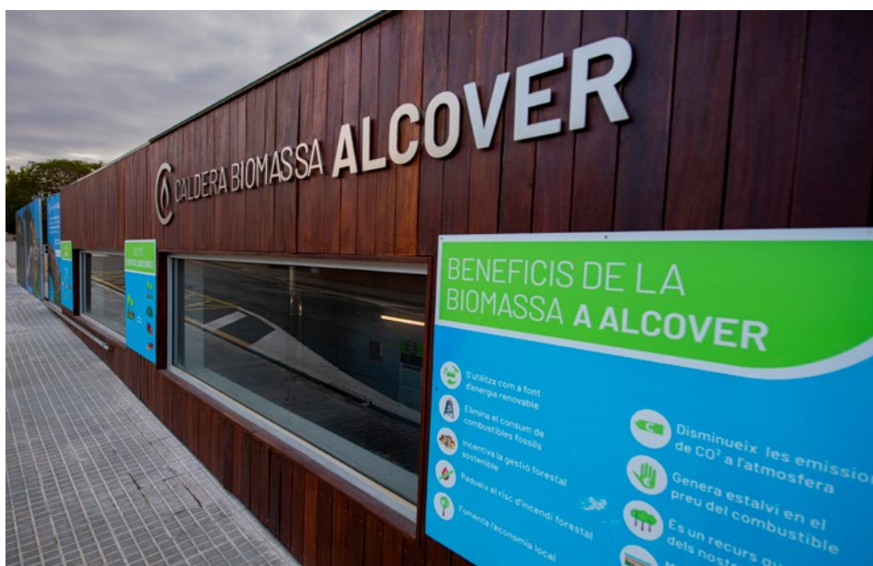
Caldera de biomassa.
