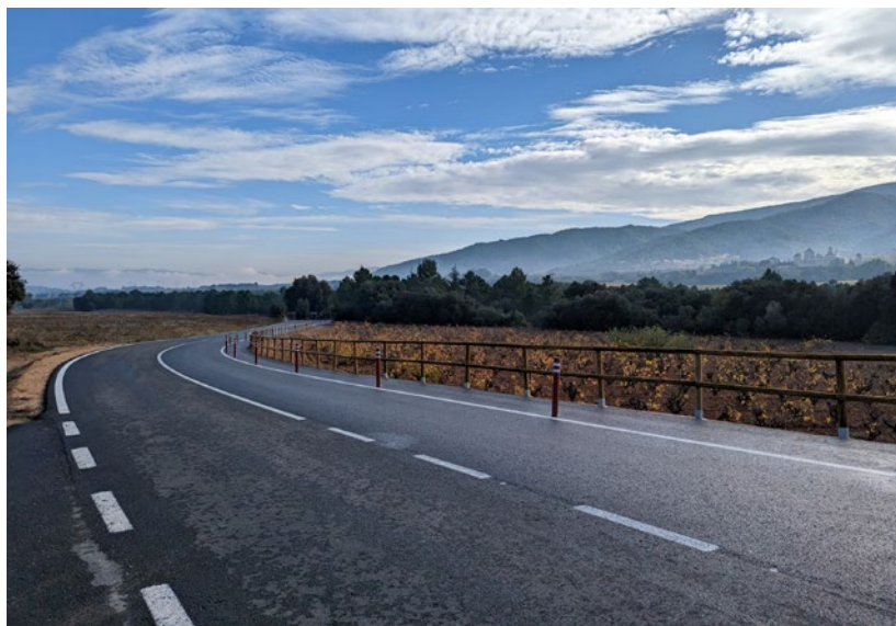
Condicionament de la carretera TV-7002, de Vimbodí a Poblet.
