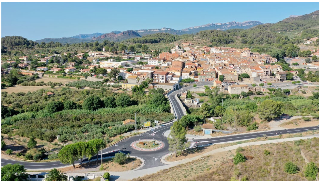
Rotonda a la intersecció de la carretera T-313 amb l'accés de Riudecanyes.
