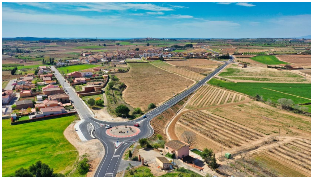
Condicionament de la carretera TP-2031, tram de la TV-2034 a la C-51.
