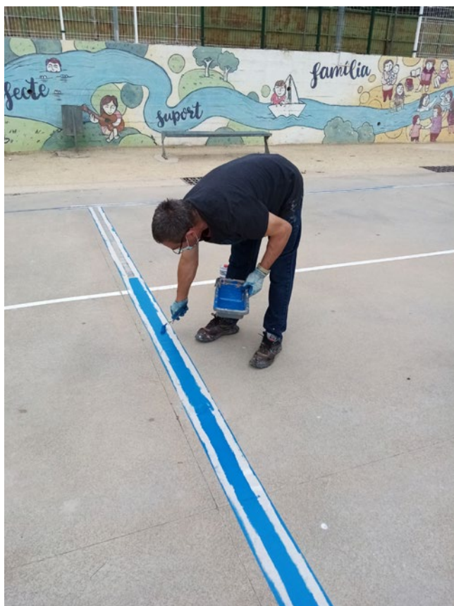
Treballs de manteniment de pintura de la zona esportiva al CPEE Sant Jordi.
