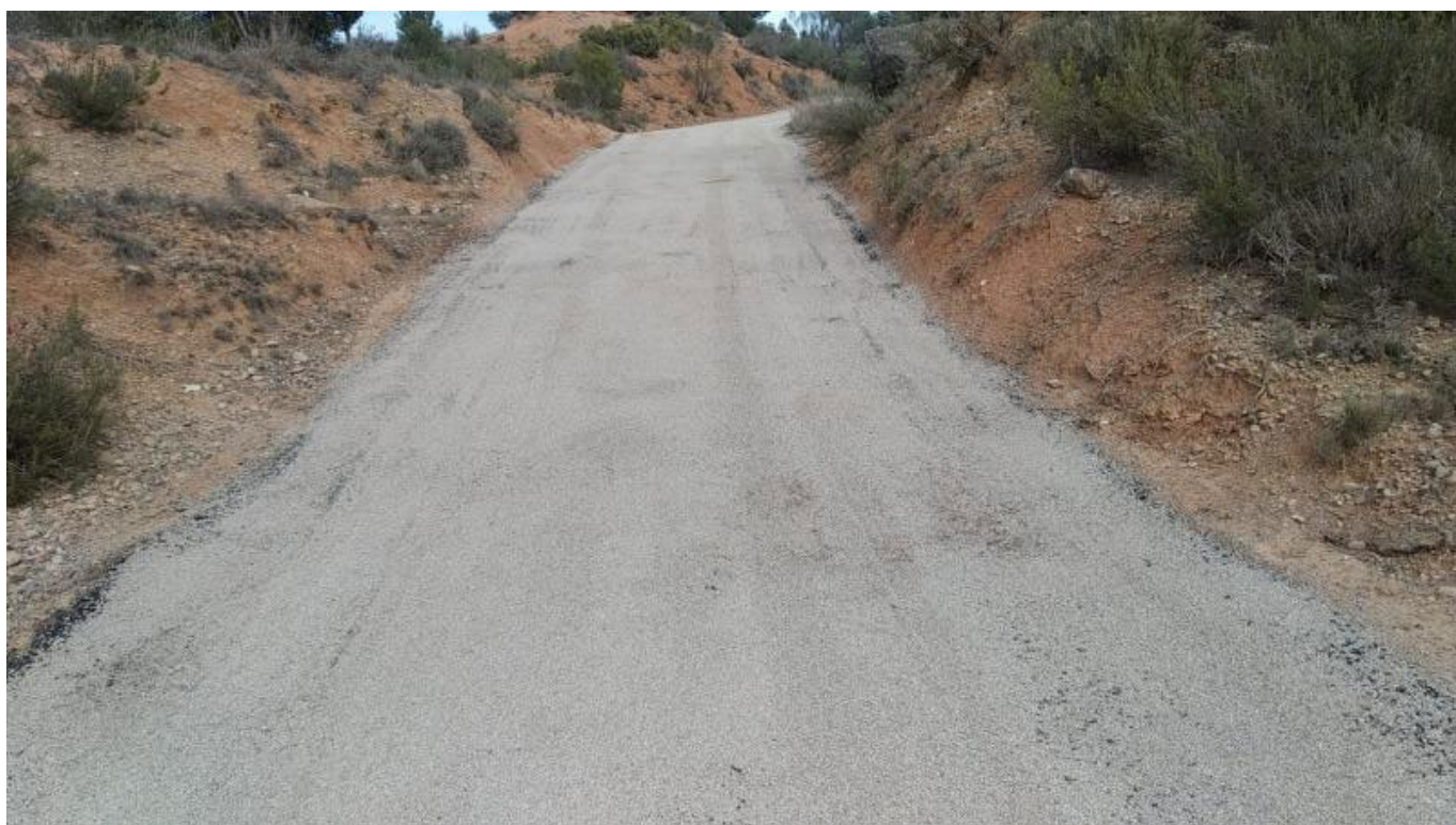
Treballs de pavimentació del camí de Tornabous. Estat inicial i final.
