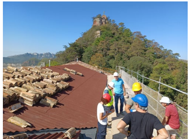
Restauració d'Escornalbou. Renovació de la coberta de l'església.
