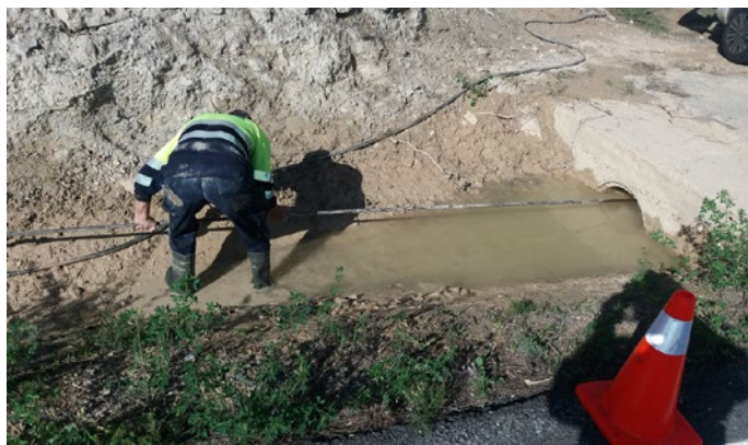
Neteja d'obres de fàbrica.
