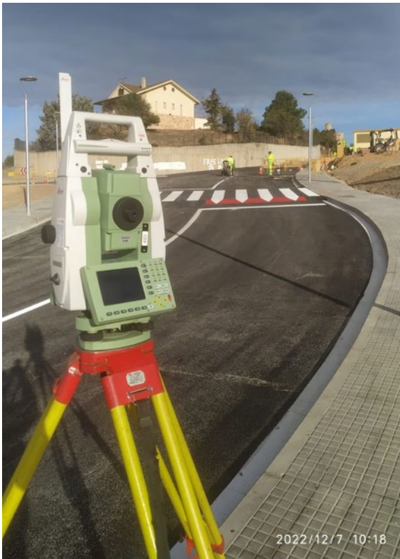
Aixecament topogràfic a la TV-2443. Vila-rodona.
