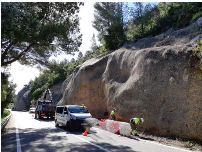
Protecció d'un talús amb malla al pk 10+650, Tortosa-Benifallet.
