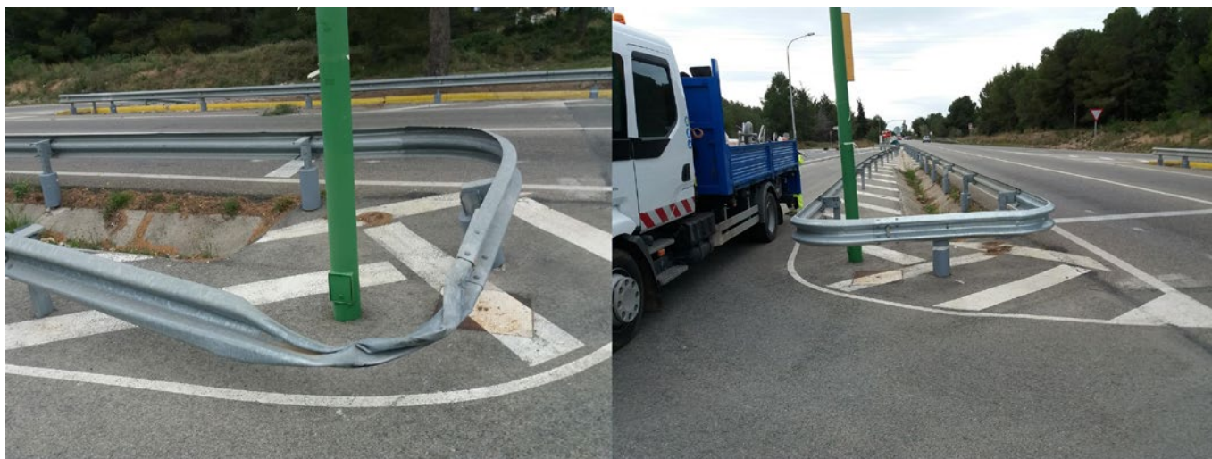
Barrera de seguretat a la carretera TP-2031.
