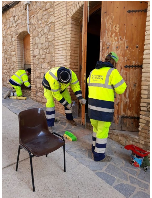
Treballs de rehabilitació de les portes a la sala d'actes de la Figuera.
