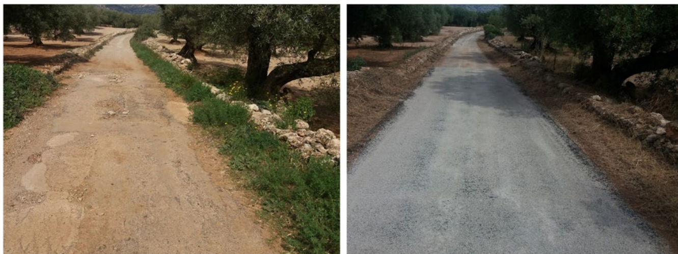
Treballs de pavimentació del camí de l'Olla. Ajuntament de Mas de Barberans. Estat inicial i final.
