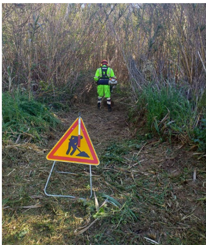
Desbrossant l'entorn de la riera d'Aiguamúrcia.
