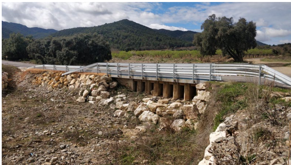
Reparació de pont i restitució de talussos de contenció a la carretera TV-7003, de Vimbodí a la T-700.
