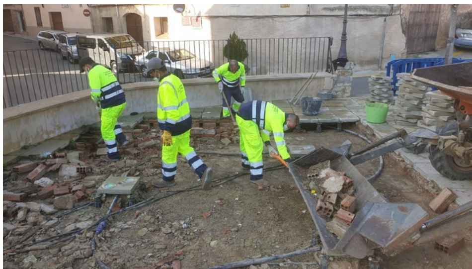
Col·locació de nou paviment a la plaça del Portal d'Avall de Tivissa.
