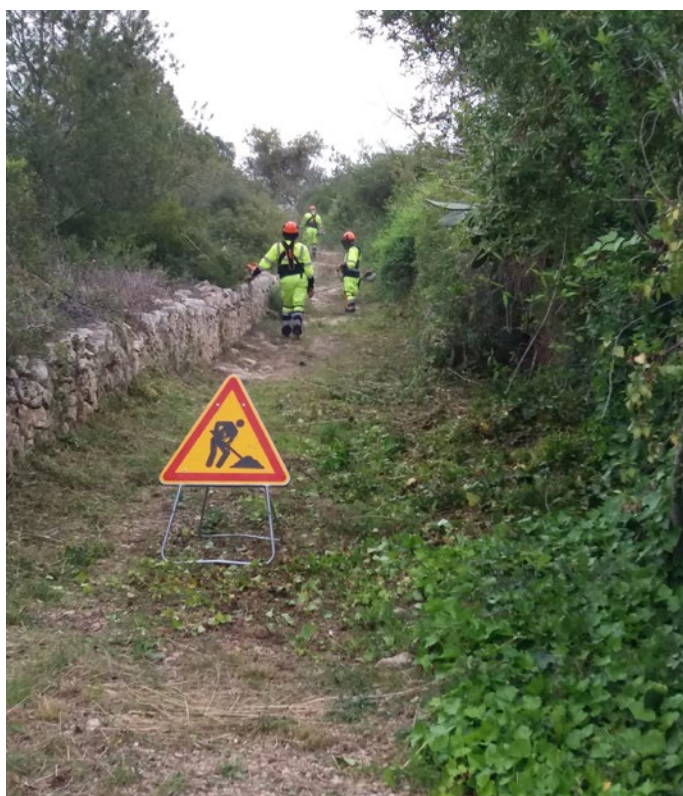
Treballs de desbrossament del camí de la Coma a la Nou de Gaià
