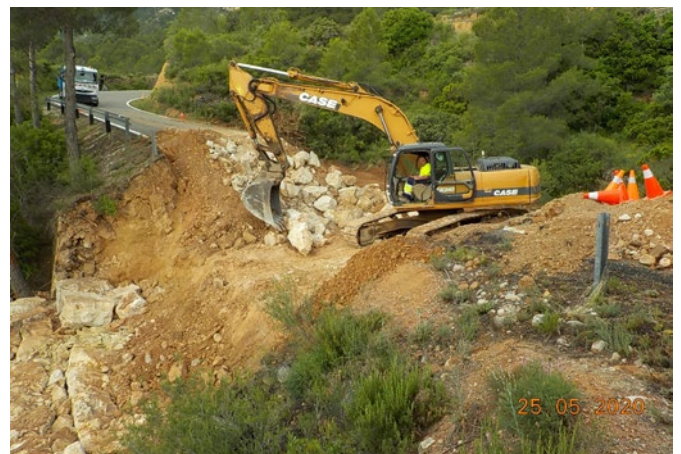
Reparació de calçada per esllavissada al pk 3+000, de la carretera de Prat de Comte a l'antiga estació de ferrocarril.
