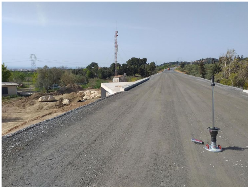
Placa de càrrega dinàmica a l'obra de la carretera T-3231, d'Almoster a la Selva del Camp.
