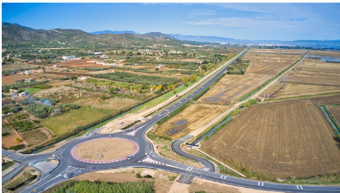
Condicionament de la carretera TV-3408, d'Amposta a Sant Carles de la Ràpita.
