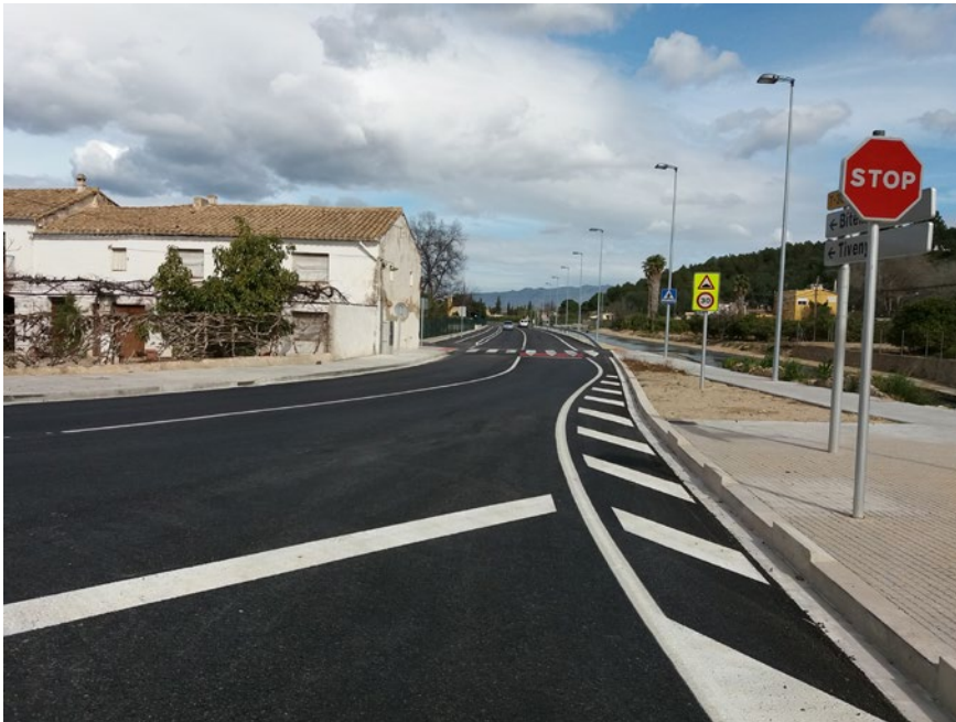
Condicionament de la carretera T-301, de Tortosa a Bitem.
