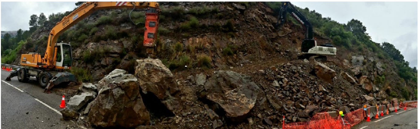
Estabilització de talús al pk 3+400, de la carretera de Gratallops al Lloar.
