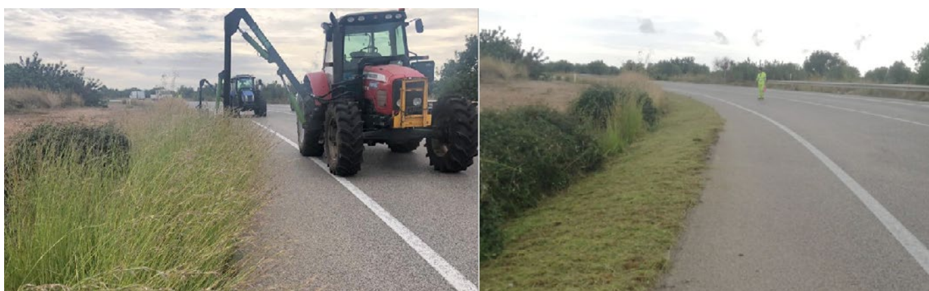
Estat abans i després de l'actuació de sega de cunetes a la carretera T-721, de la C-422 a la Pobla de Mafumet.
