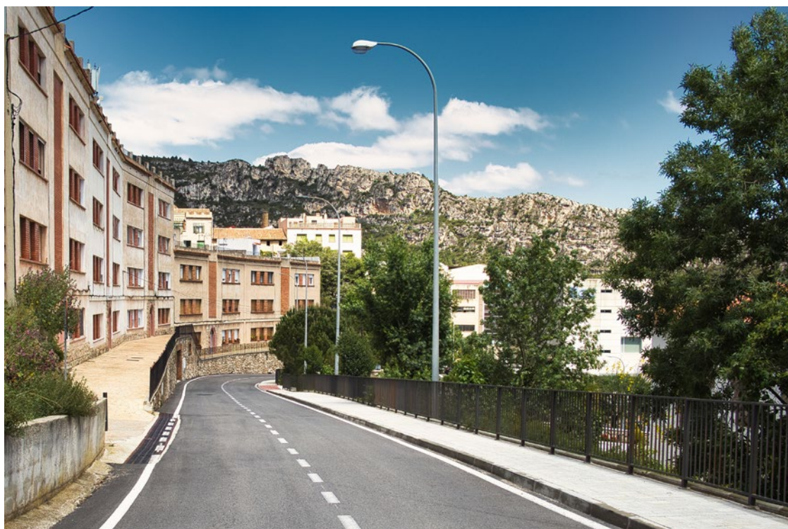
Condicionament de la travessera de la Riba. Carreteres C-240z i TV-7044.
