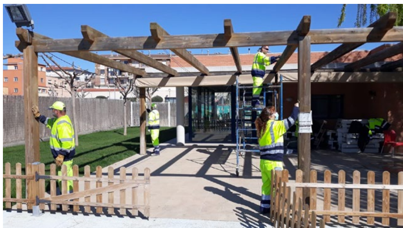
Treballs de manteniment a la piscina municipal de Sarral.
