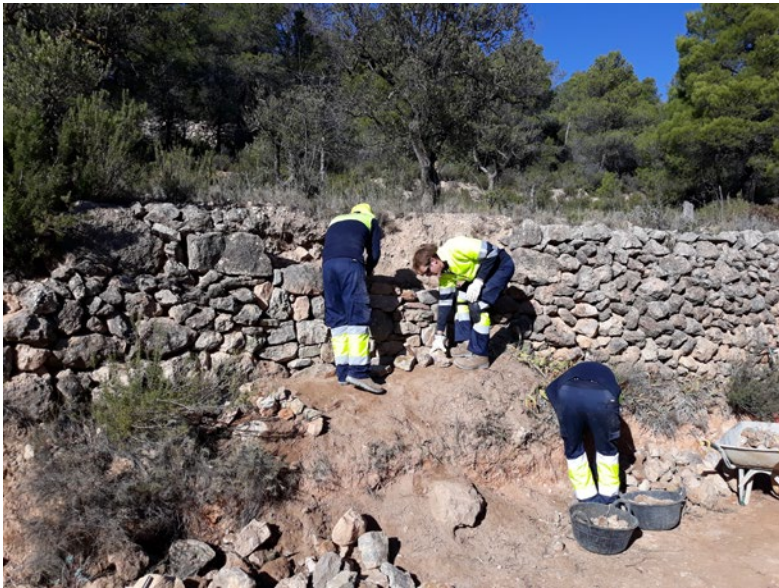
Rehabilitació d'un marge de pedra seca al camí vell de la Foia de Cabacés.
