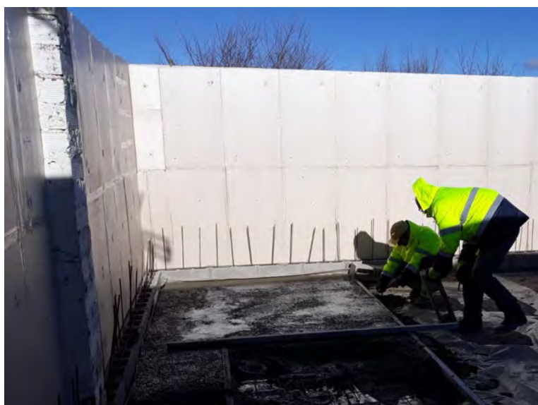
Execució de tasques de paleta a Montblanc.
