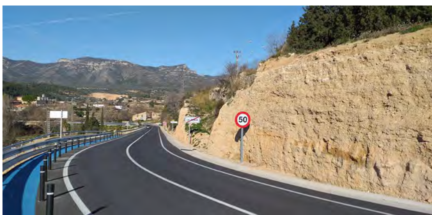
Condicionament de la carretera T-1050 de la Sénia a la CV-100.
