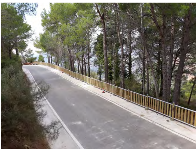
Millores puntuals de seguretat i drenatge a la carretera T-3225, a Siurana.
