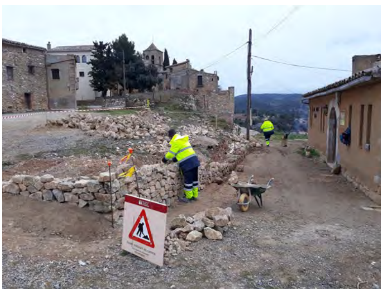
Treballs de construcció d'un marge de pedra seca a Albarca (Ulldemolins).
