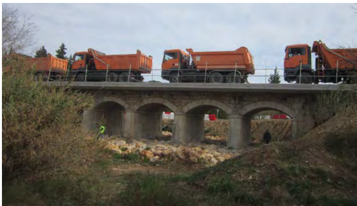
Prova de càrrega i control a l'ampliació d'un pont de la carretera T-301, a Tortosa.
