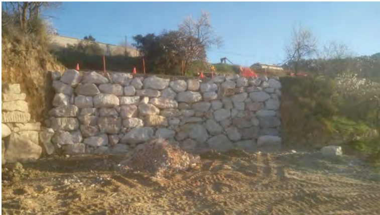
Construcció d'un mur d'escullera a la carretera TV-2245, PK 1+000, d'Alió a la T-224.
