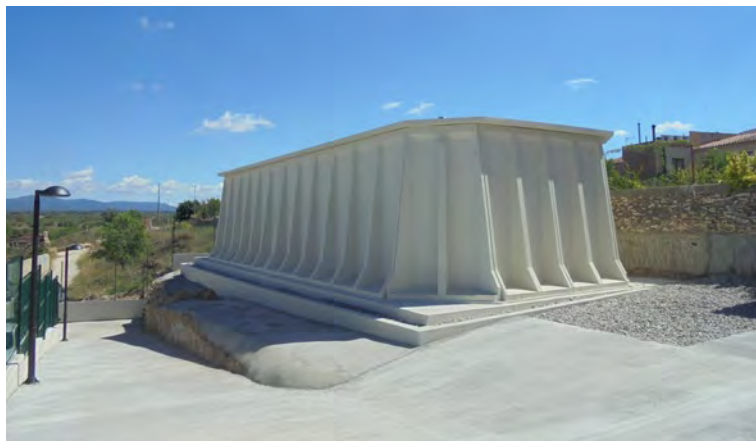
Nou dipòsit de subministrament d'aigua potable d'Alió.
