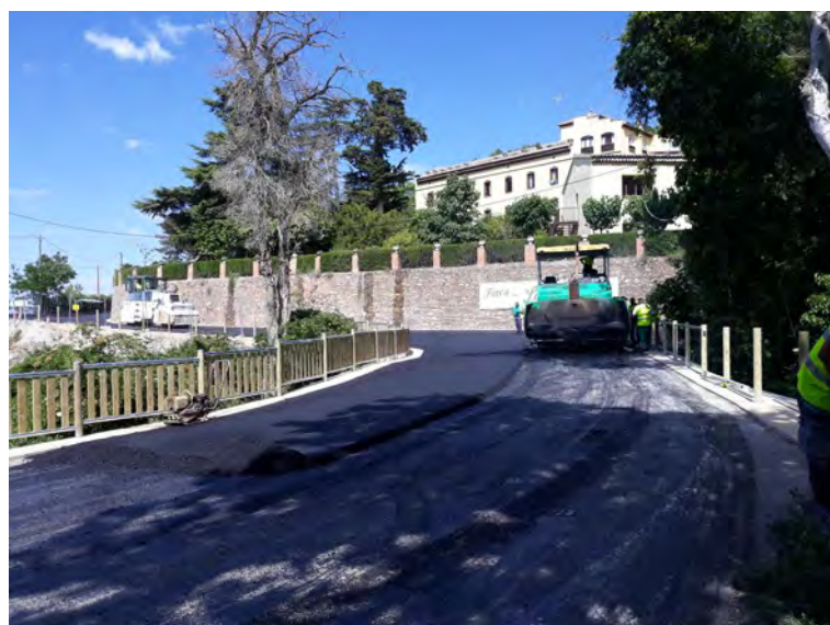
Execució de la capa de trànsit a la carretera TV-7007, a les Masies.
