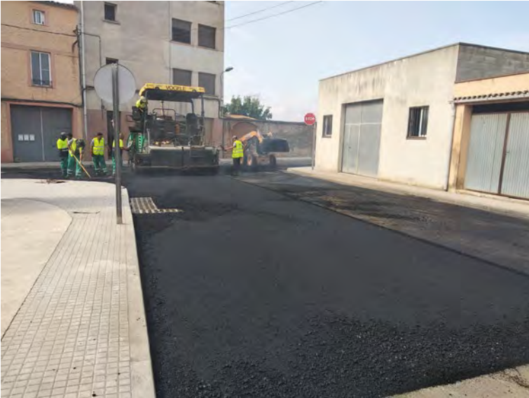
Reforçament del ferm a la carretera T-722, el Rourell.
