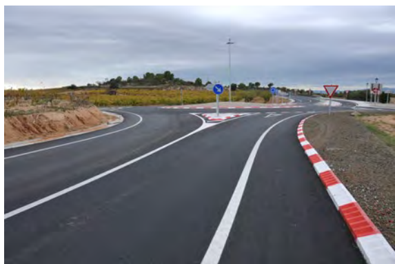
Condicionament de la carretera TP-2031, de Tarragona a la C-51. Tram l'Argilaga - TV-2034.
