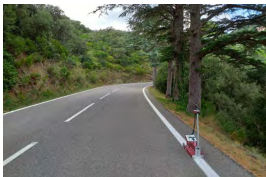
Mesures amb el retroreflectòmetre per a les marques viàries aplicades sobre la calçada.
