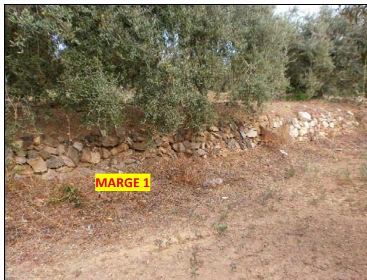
34, 35.- Imatge de detall dels marges de pedra seca, MARGE 1 i MARGE 2.
