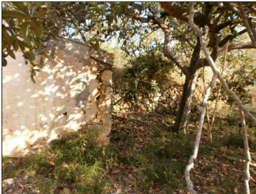
19, 20.- Imatge de detall de la casa de pagès 3, i al fons un dels marges de pedra seca propers existents.
