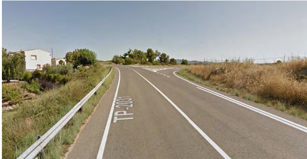
PK 20+788 (Intersecció nord de Bràfim)
