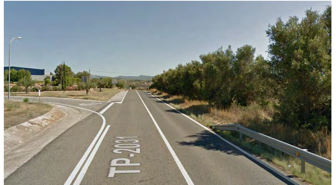
PK 22+615 (Accés nord al polígon industrial Alió - Bràfim)
