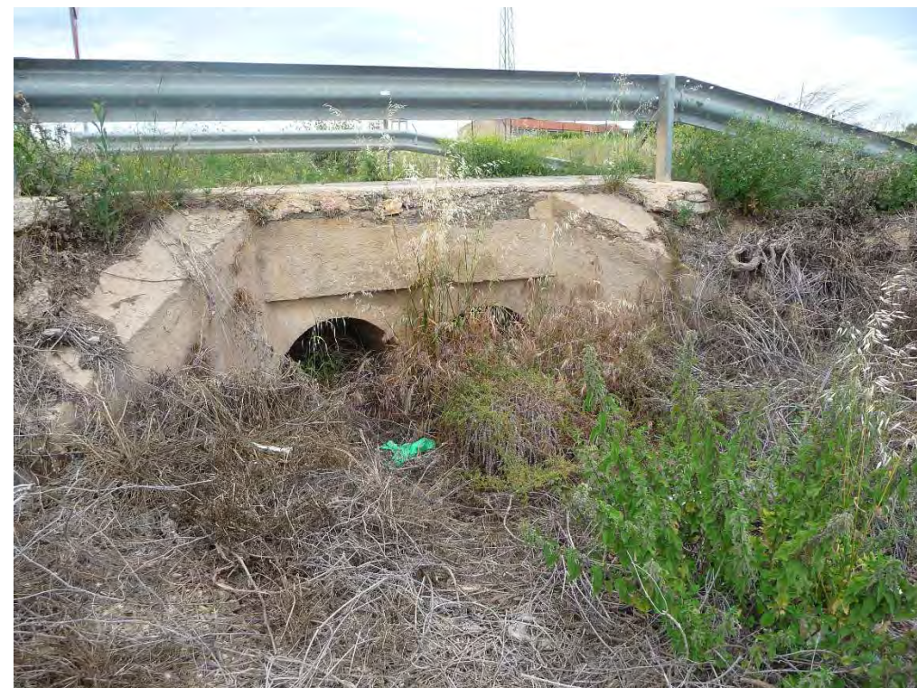
Boca de sortida obra de drenatge OD-2.1.
