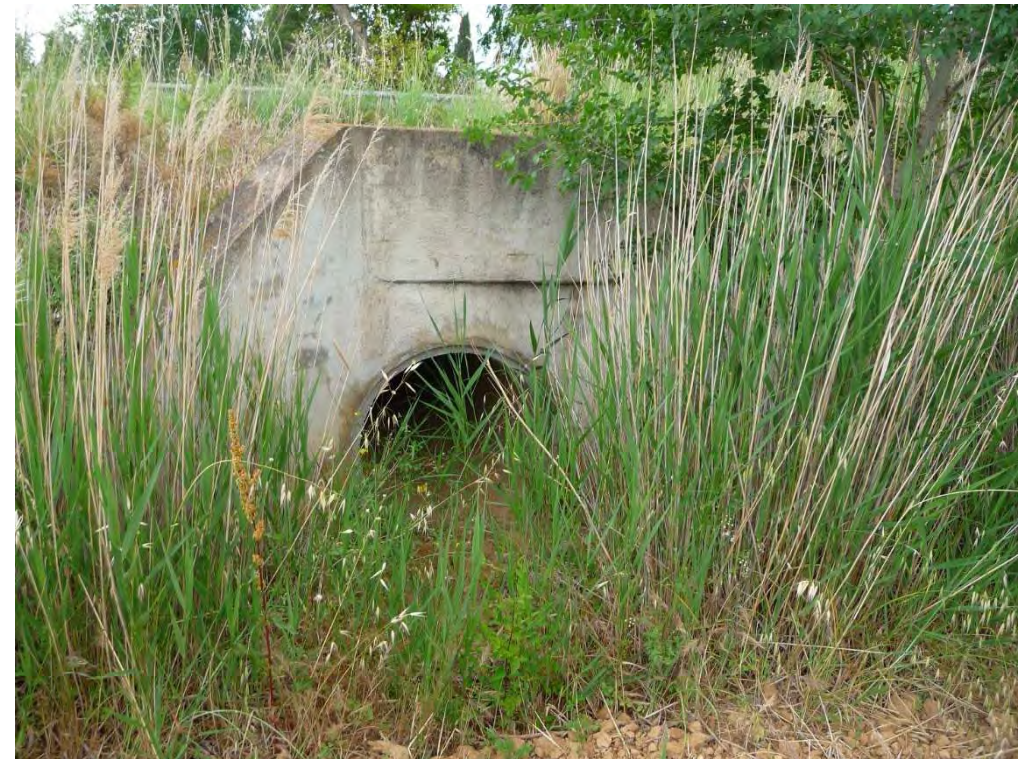
Boca d'entrada obra de drenatge OD-1.5.
