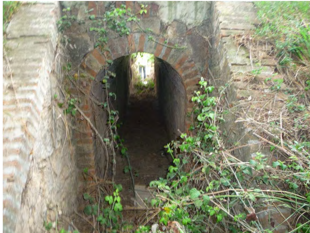
Boca d'entrada obra de drenatge OD-0.6.
