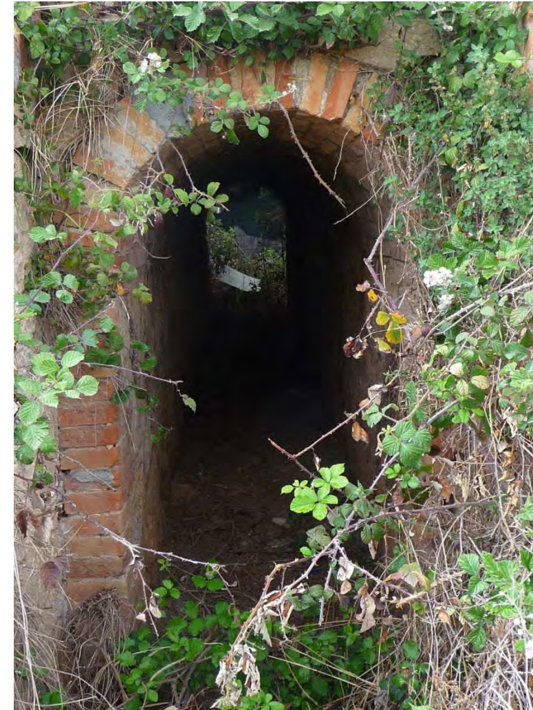
Boca de sortida obra de drenatge OD-0.6.
