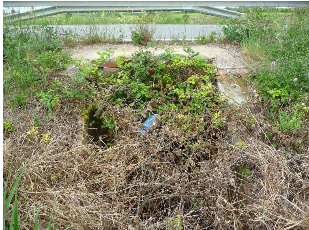
Boca d'entrada obra de drenatge OD-1.1.
