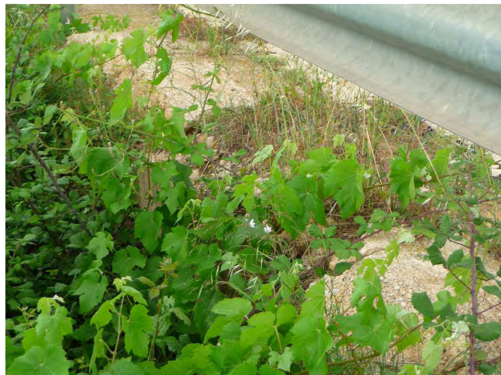
Boca de sortida obra de drenatge OD-1.8.
