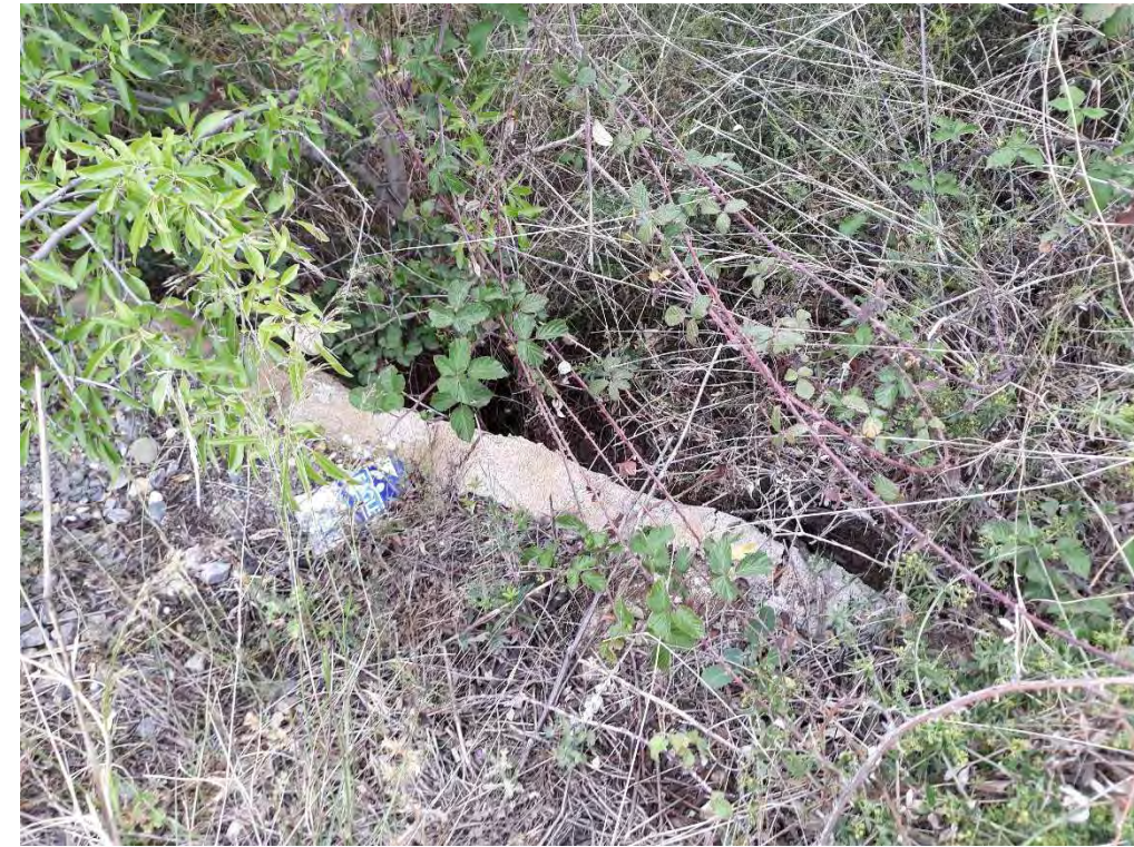
Boca de sortida obra de drenatge OD-4.0
