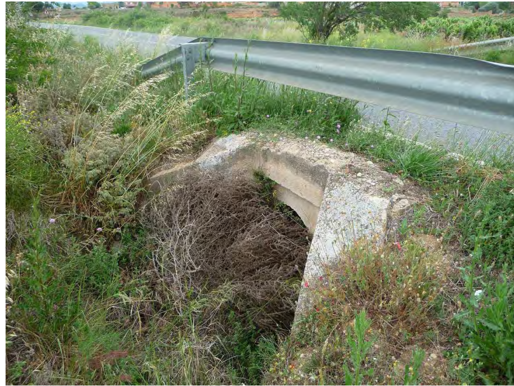
Boca d'entrada obra de drenatge OD-2.3.
