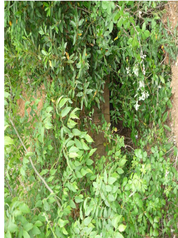
Boca d'entrada obra de drenatge OD-2.6.
