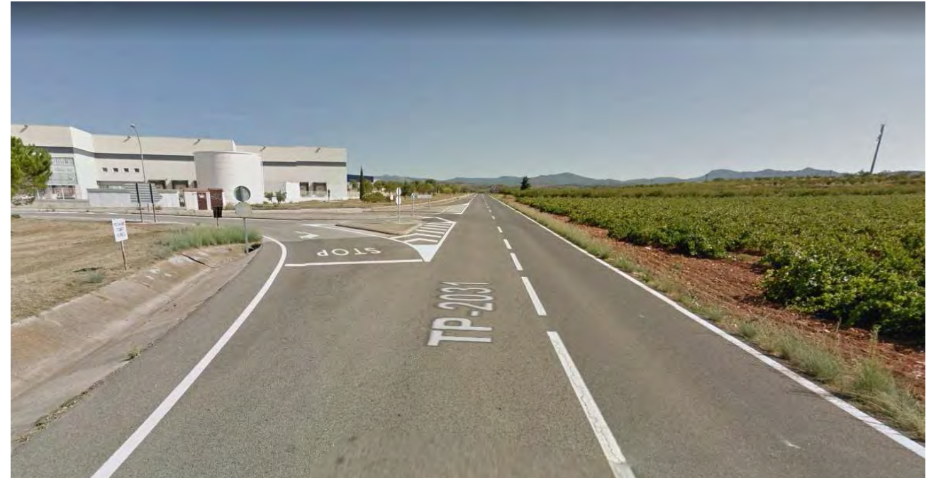
PK 22+260 (Accés sud al polígon industrial Alió - Bràfim)
