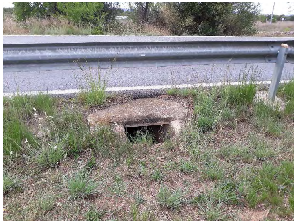
Boca d'entrada obra de drenatge OD-4.0
