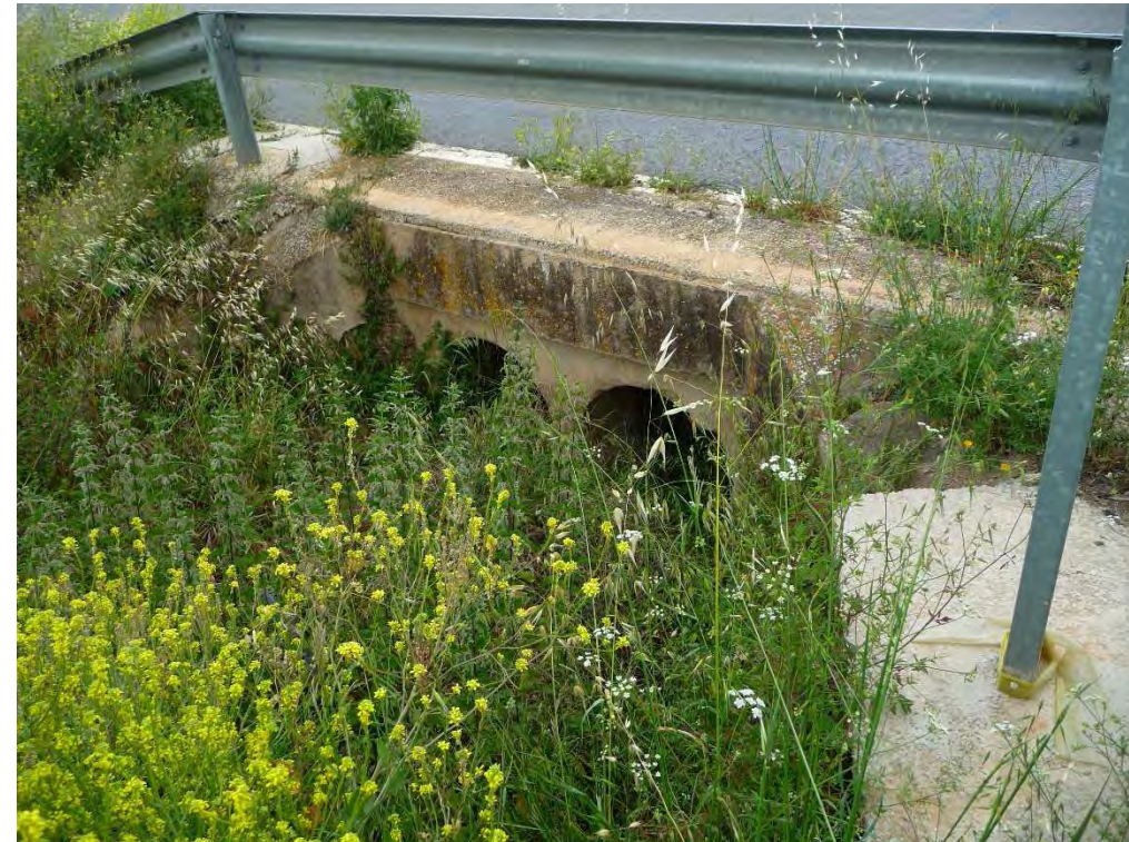
Boca d'entrada obra de drenatge OD-2.1.
