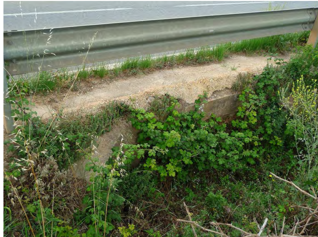
Boca d'entrada obra de drenatge OD-1.8.
