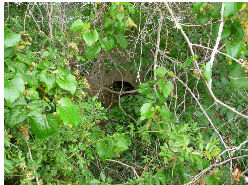
Boca de sortida obra de drenatge OD-1.5.
