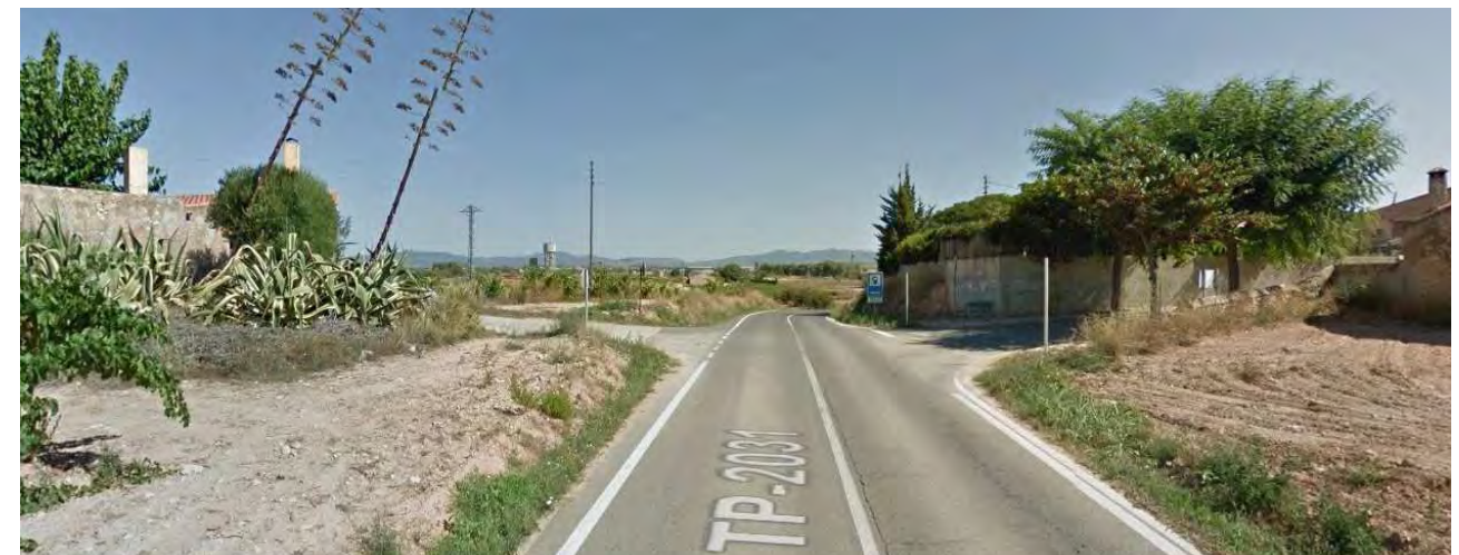
PK 20+070 (Intersecció amb el camí a Puigpelat i el c. Major de Bràfim)
