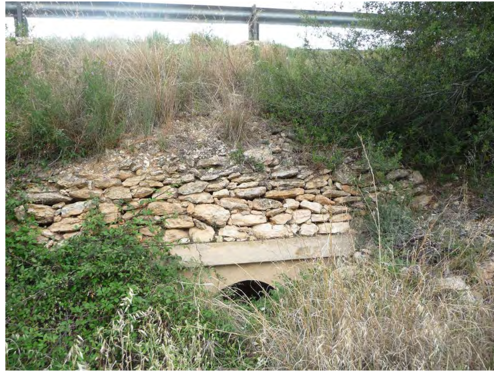
Boca de sortida obra de drenatge OD-2.6.
