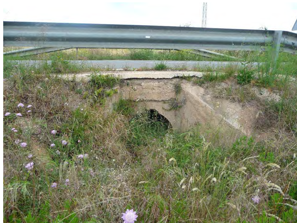
Boca de sortida obra de drenatge OD-2.3.
