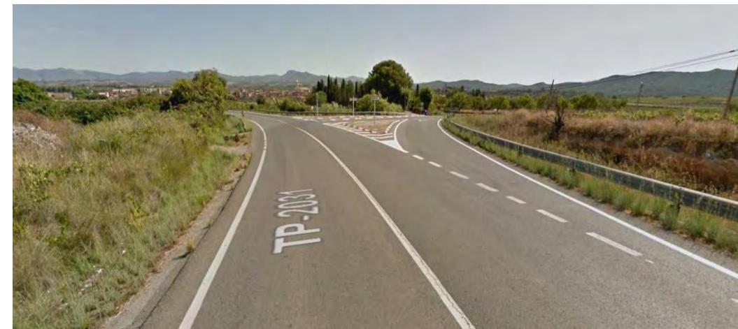
PK 19+345 (Intersecció sud de Bràfim)
